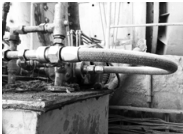
شکل ۷- استفاده از شلنگ فشار قوی ۱ اینچ با محاسبه دبی عبوری از خط فشار
